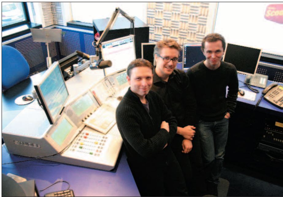
Studio d'antenne principal : Logiciel Zenon Media, Console Studer OnAir 2000 et Telos N×12
